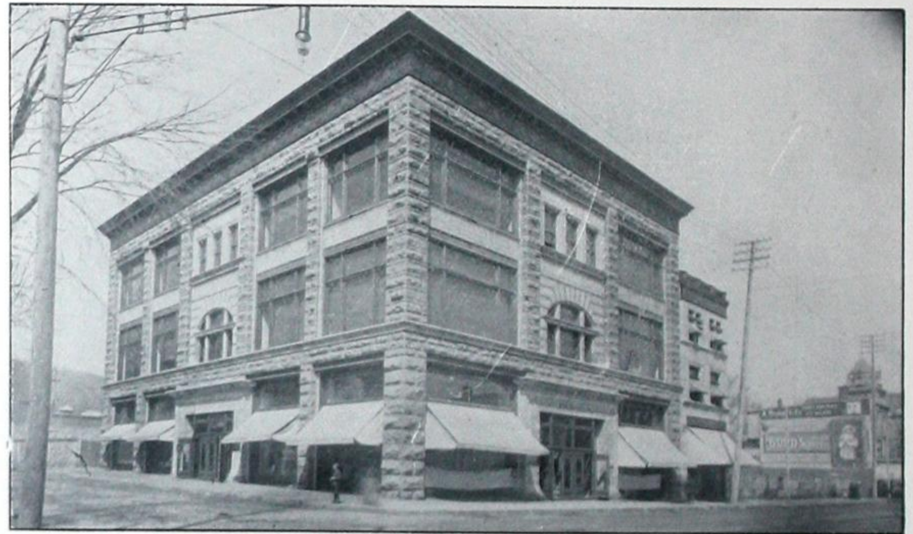
Fig. 186.—Jas. A. Ogilvy & Sons' Store, Montreal.
